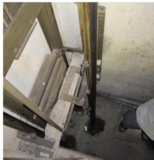
Detalhe do poço.
