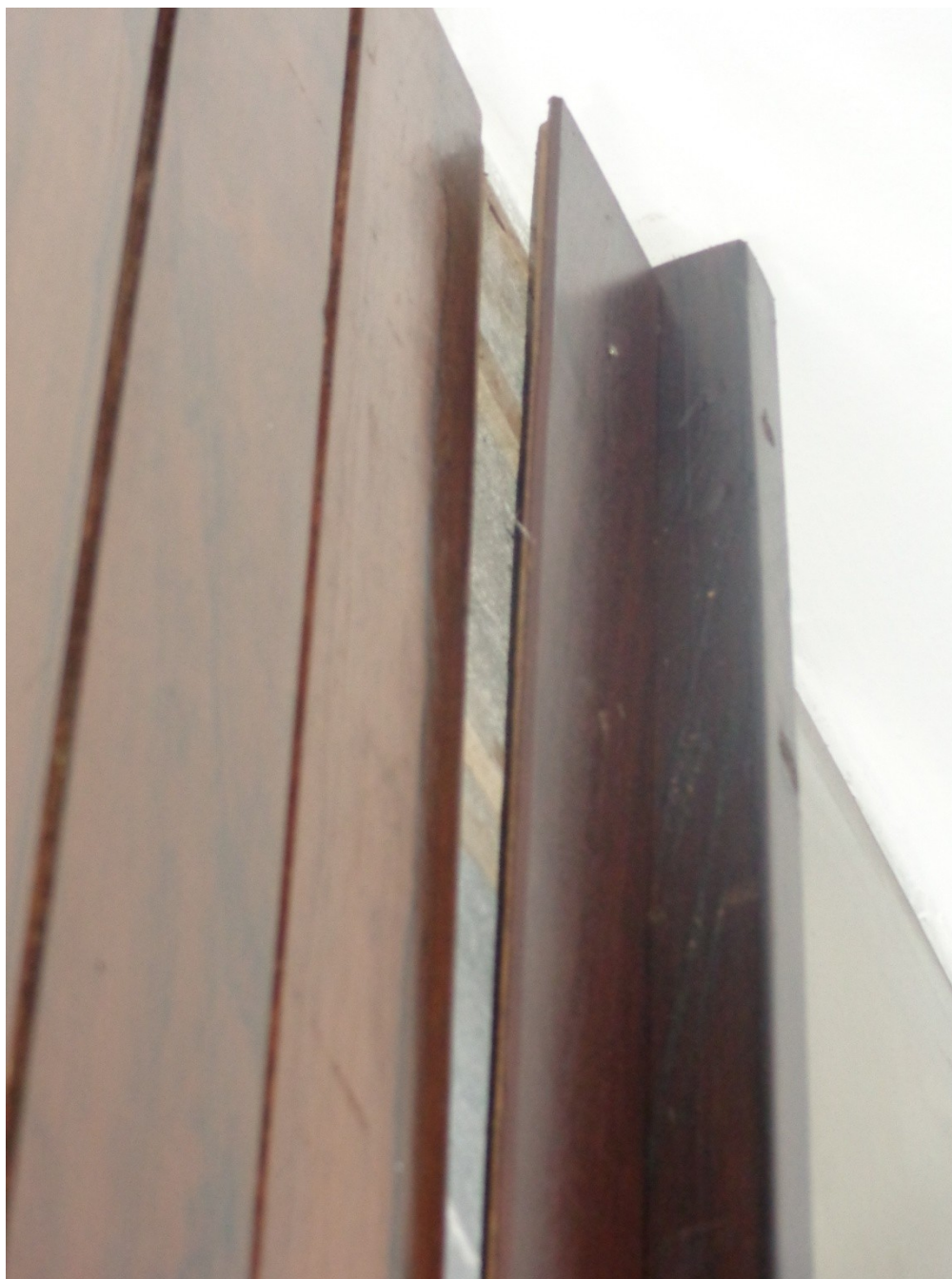
FOTO 23 – Modo de fixação do lambri de Jacarandá e Pau-Ferro na fachada do elevador a ser substituído no Edifício Principal no pavimento térreo. O elemento onde se encontra a botoeira atual deverá ser objeto de resuperação conforme especificações do Anexo 04 do edital.
