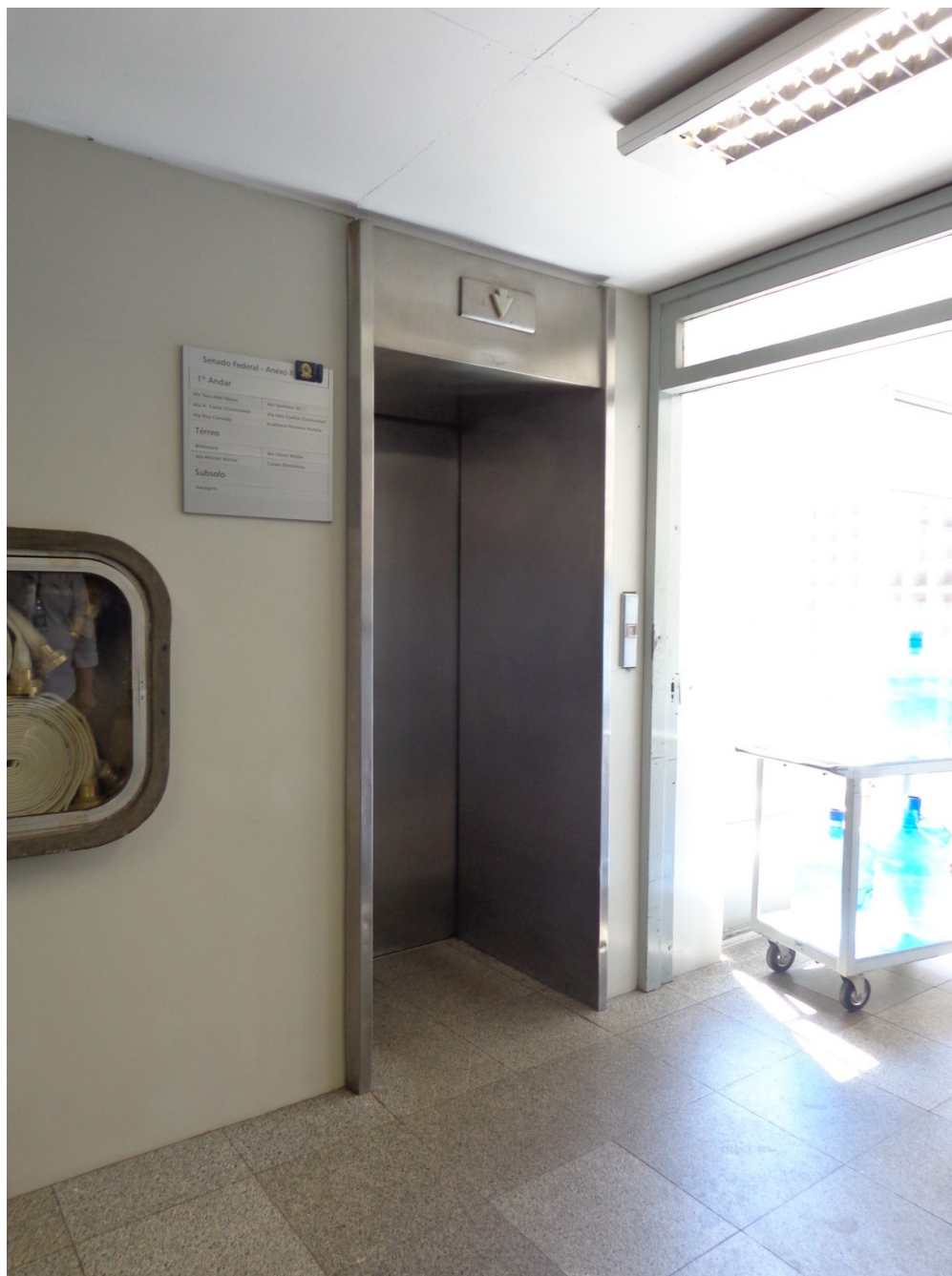
FOTO 39 – Marcos, soleiras, batentes, fachada, indicadores de posição e movimento, botoeira e sinalização do elevador de serviço do Bloco A do edifício Anexo II no primeiro pavimento. As peças de Laminado Decorativo de Alta Pressão na fachada para instalação de botoeira na nova posição deverão ser substituídas conforme especificações do Anexo 04 do edital.
