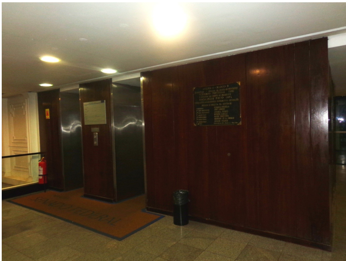
FOTO 46 – Marcos, soleiras, batentes, fachada, botoeira e sinalização dos elevadores do Bloco B do edifício Anexo II no primeiro pavimento. As peças de Ipê Roxo na fachada para instalação de botoeiras nas novas posições deverão ser substituídas conforme especificações do Anexo 04 do edital.
