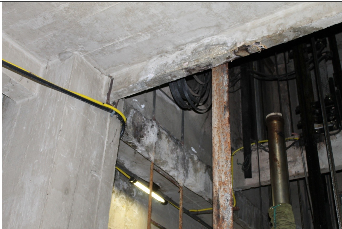
FOTO 3 – Trilhos do elevador e vigas no poço dos elevadores do edifício Anexo I.
