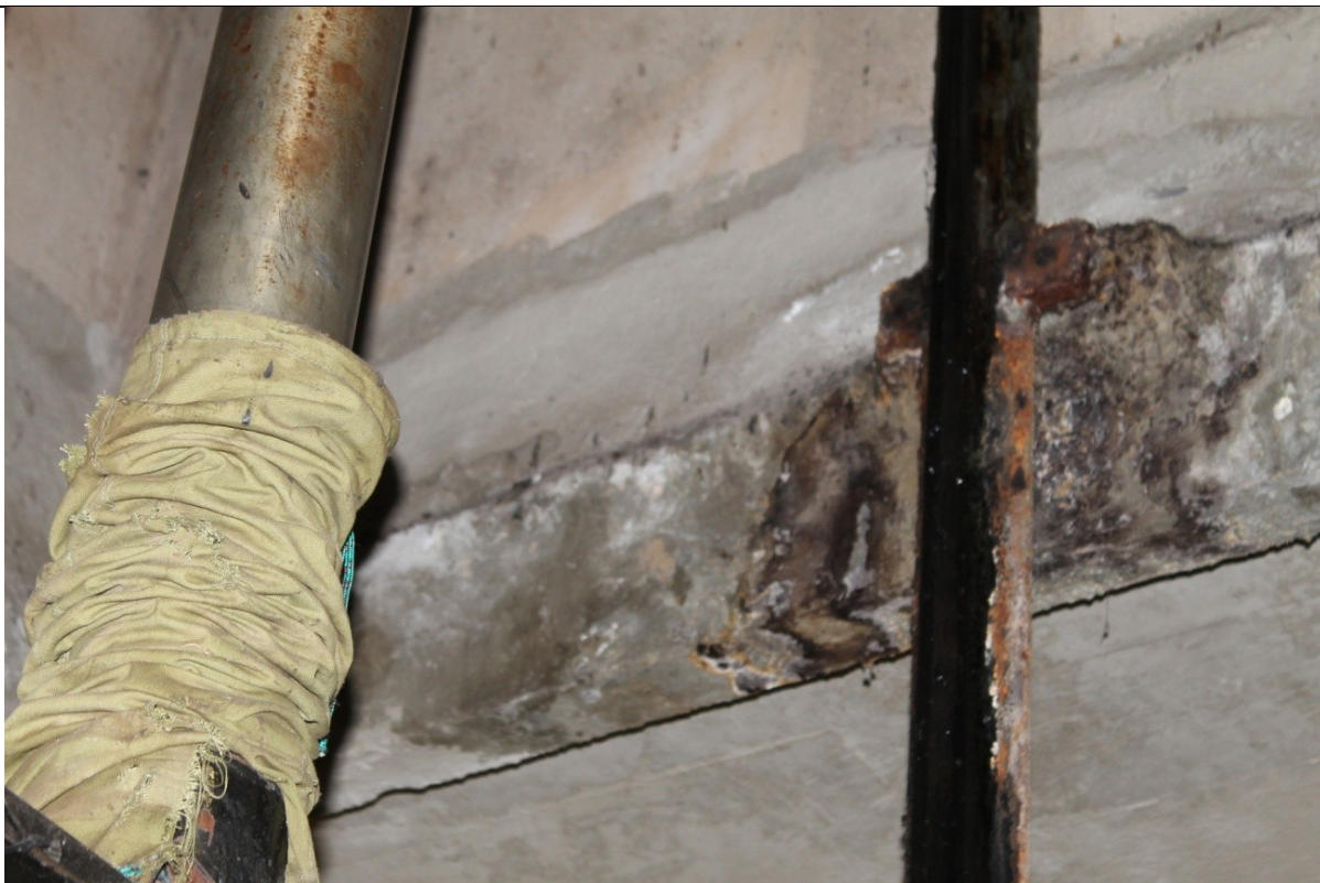
FOTO 4 – Suporte de sustentação de guia de elevador e viga no poço dos elevadores do edifício Anexo I.
