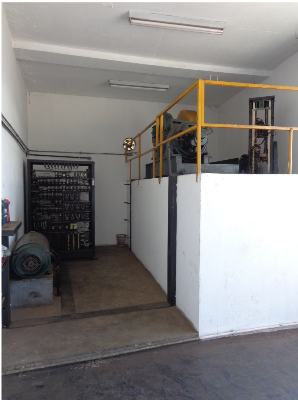
FOTO 37 – Casa de máquinas do elevador de serviço do Bloco A do edifício Anexo II. Os elementos deverão ser substituídos conforme especificações do Anexo 04 do edital.
