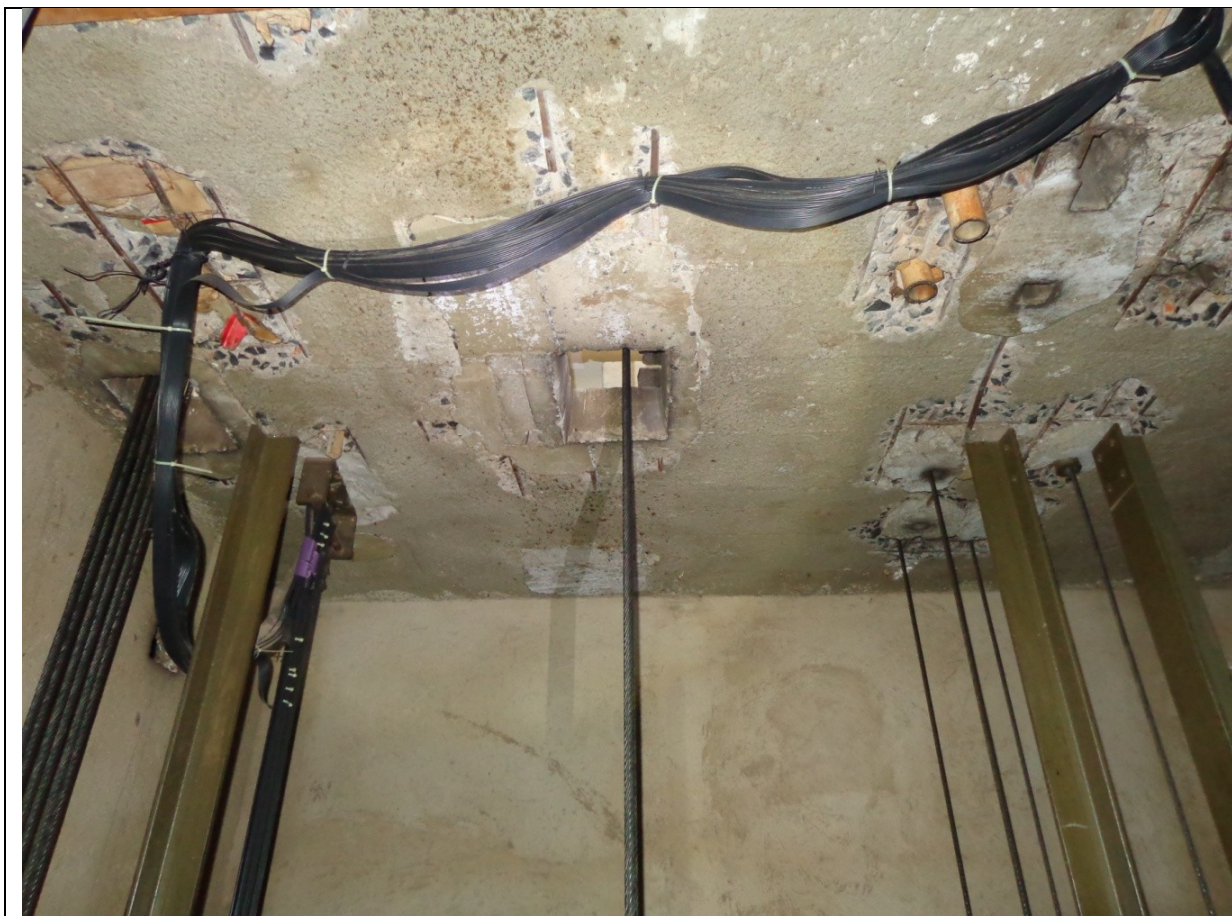
FOTO 9 – Face inferior da laje superior da caixa dos elevadores do edifício Anexo I, no 27º andar.
