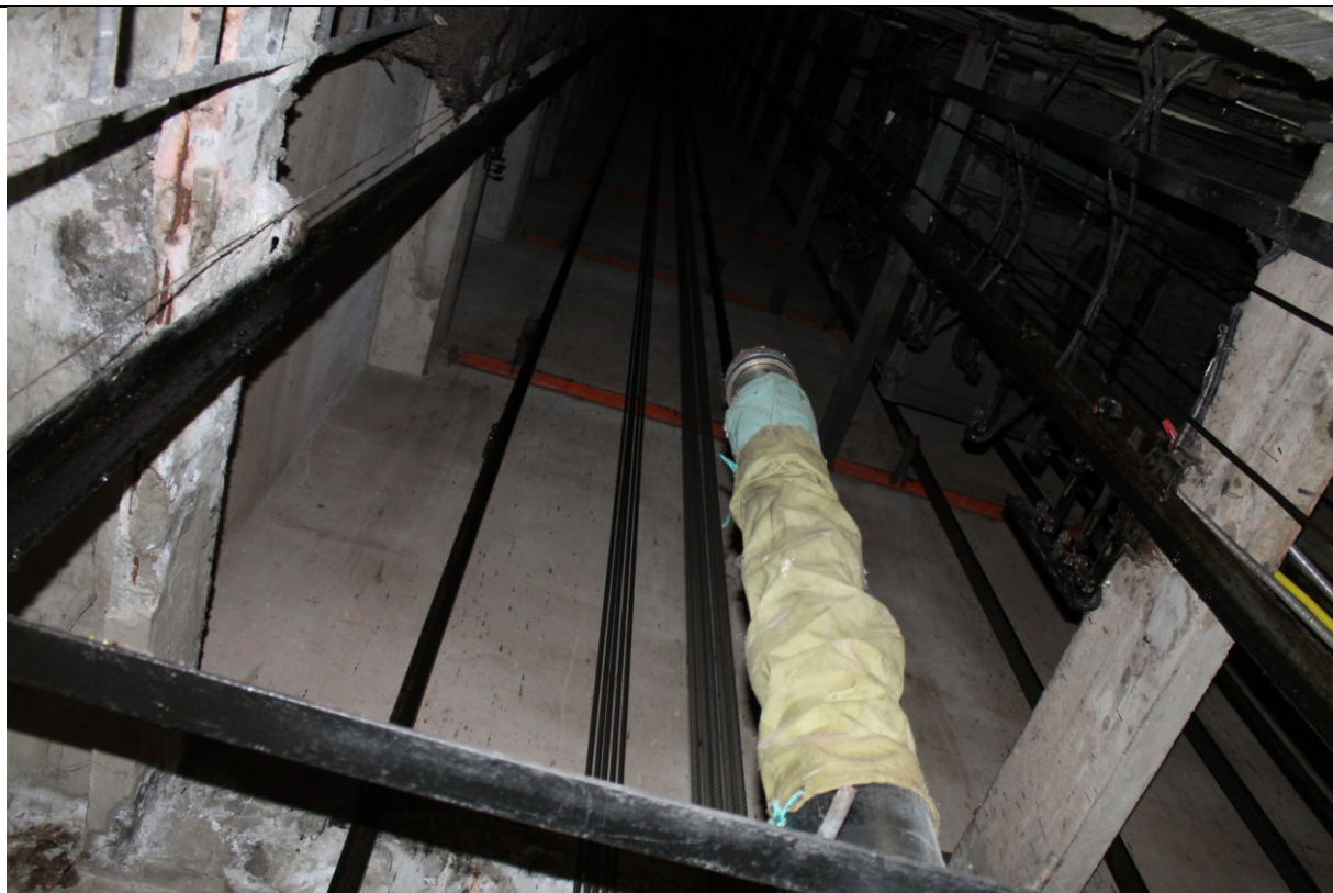
FOTO 7 – Caixa de corrida de elevador do edifício Anexo I.
