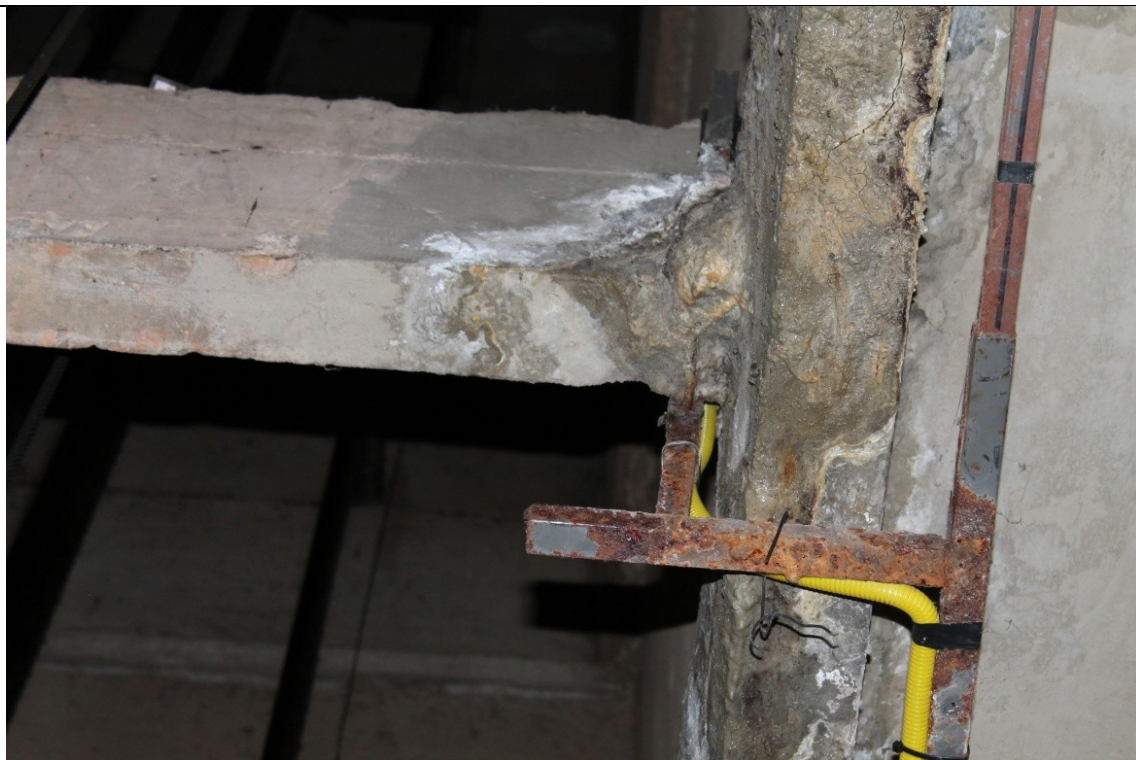
FOTO 8 – Viga do edifício Anexo I inclusive com passagem de instalações elétricas.
