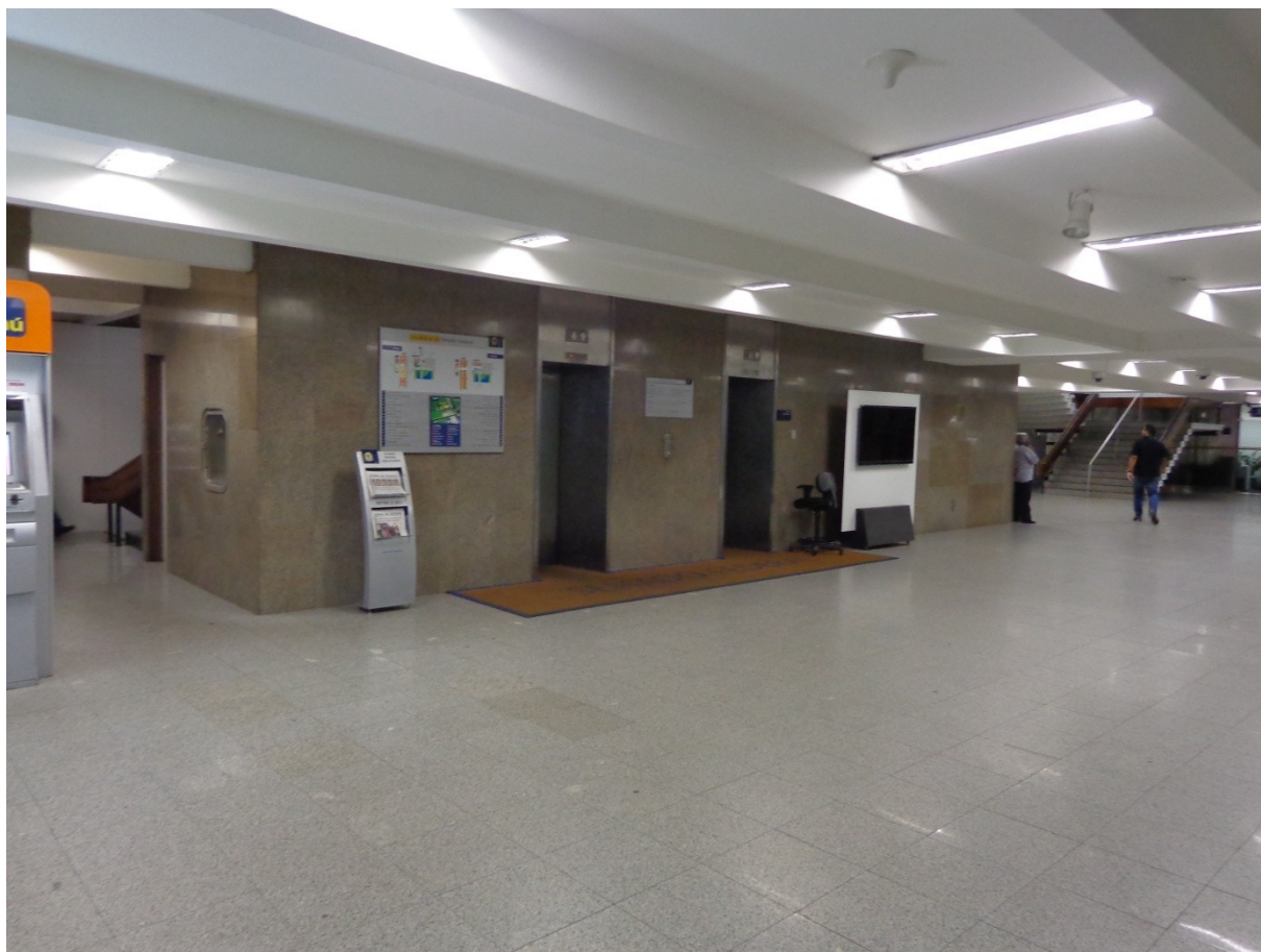
FOTO 34 – Marcos, soleiras, batentes, espelhos externos, fachada, indicadores de posição e movimento, botoeira e sinalização dos elevadores sociais do Bloco A do edifício Anexo II no pavimento térreo. As peças de granito na fachada para instalação de botoeiras nas novas posições deverão ser substituídas conforme especificações do Anexo 04 do edital.
