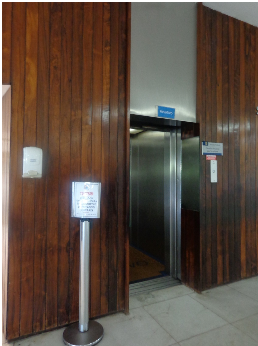
FOTO 22 – Marcos, soleiras, batentes, espelhos externos, lambri na fachada, botoeira e sinalização do elevador a ser substituído no Edifício Principal no pavimento térreo.
