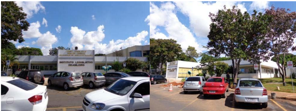
Unidade de Apoio 5
