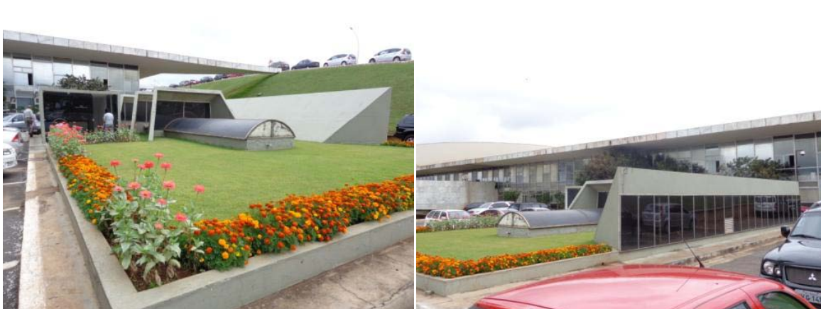
Unidade Infrabásilar (Casa de Máquinas 1)
