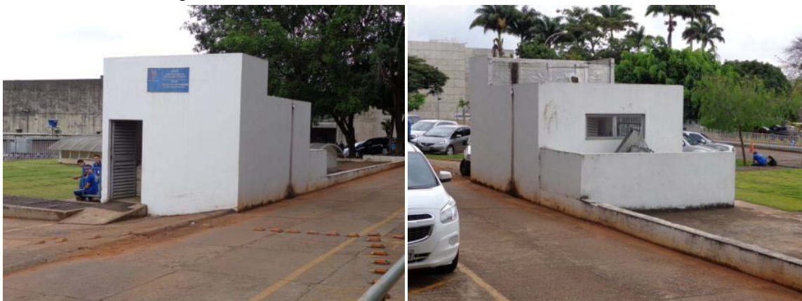
Casa de Máquinas 2
