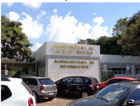
Unidade de Apoio 3
