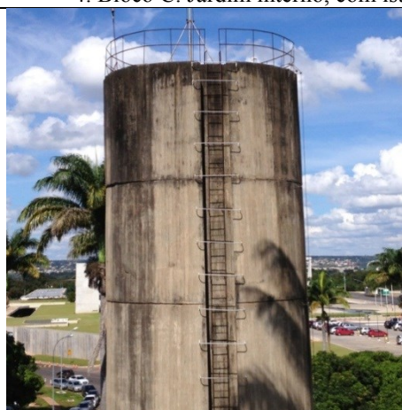
6. Castelo d'água. Vista do topo.
