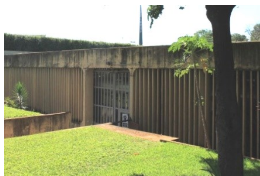
7. Casa de Máquinas 3. Vista geral.
