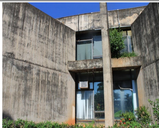
1. Bloco A. Exterior, Fachada Leste
