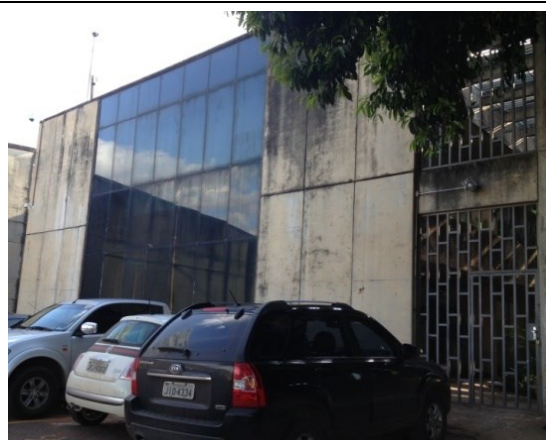
4. Bloco C. Fachada Leste
