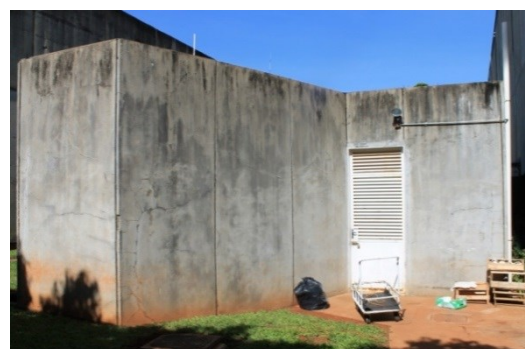
10. Cozinha anexa ao Bloco B.
