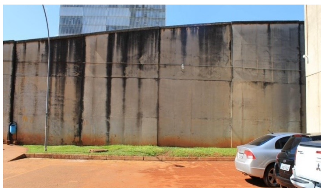
7. Muro de arrimo. Vista geral
