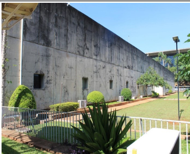
1. Bloco A. Exterior, fachada Norte, vista geral
