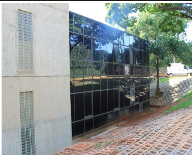
1. Bloco A. Exterior, Fachada Oeste
