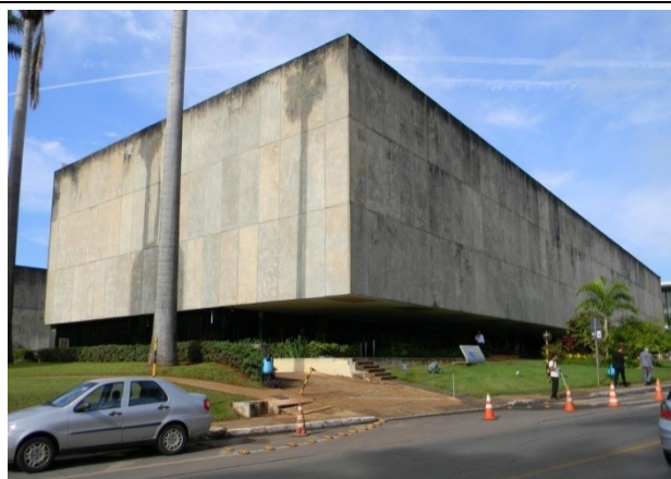
3. Bloco B. Vista Geral
