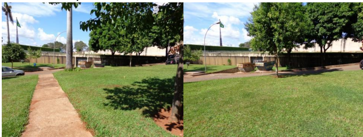
Casa de Máquinas 3
