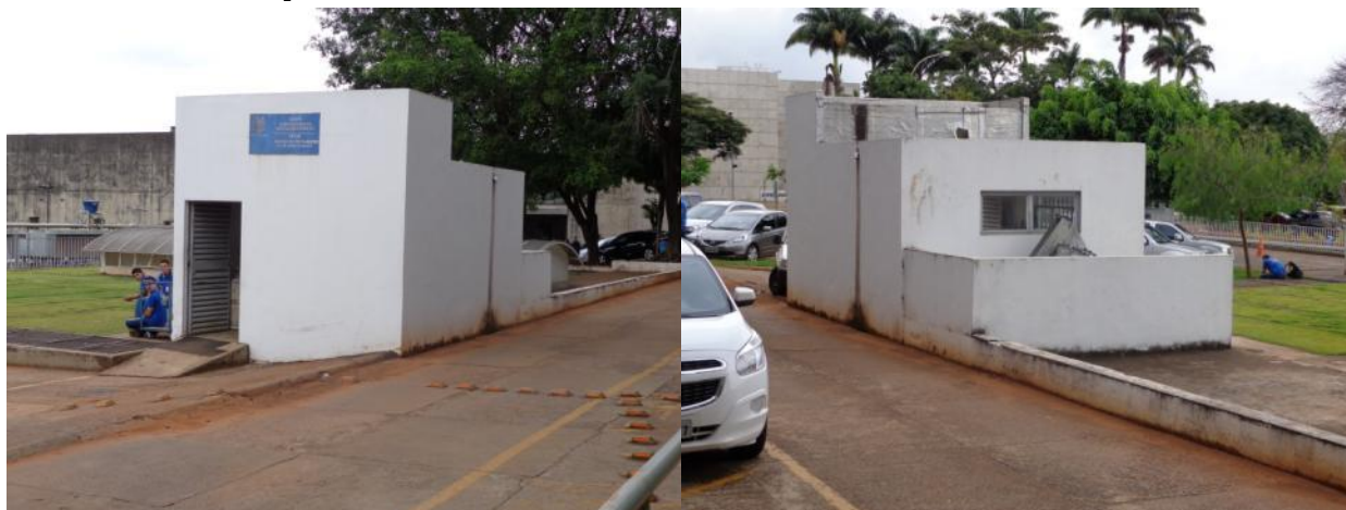
Casa de Máquinas 2
