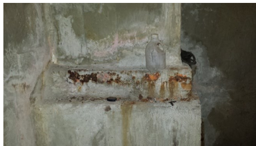
Foto 5 - Pilar de fundação, com base metálica, no poço do elevador, em janeiro de 2014.
