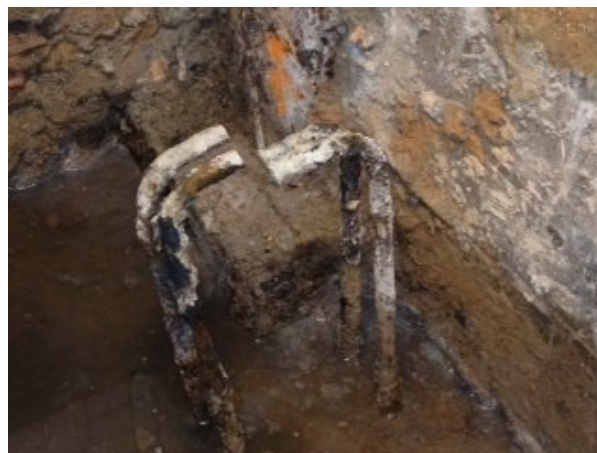
Foto 3 - Detalhe dos arranques da estaca, em dezembro de 2013.
