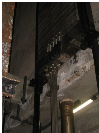
Foto 9 - Viga utilizada para fixação das guias dos elevadores, em janeiro de 2014.
