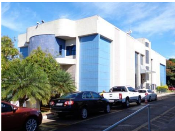
Unidade de Apoio 6 (Bloco 13)
