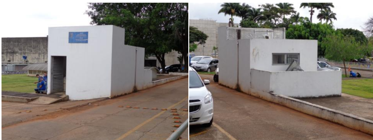
Casa de Máquinas 2
