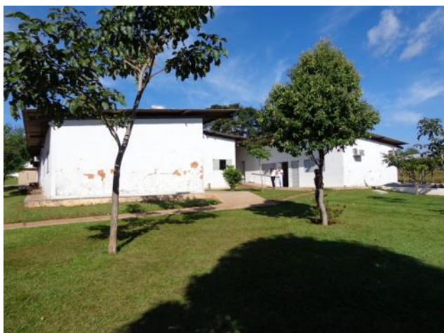
Unidade de Apoio 7 (Bloco 18)
