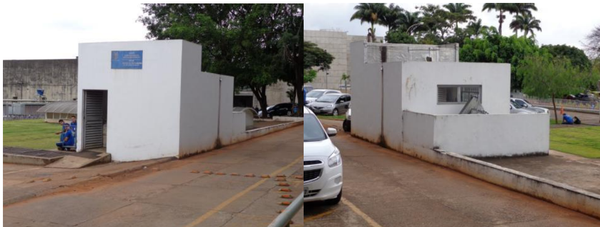
Casa de Máquinas 2
