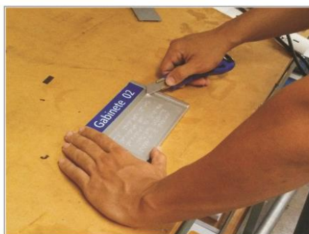
Remoção do adesivo em Braille
