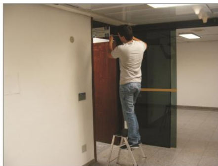
Instalação das placas no Gabinete
