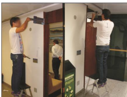
Remoção das Placas do Gabinete
