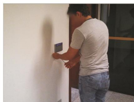
Instalação da Placa já alterada
