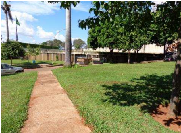
Casa de Máquinas 3
