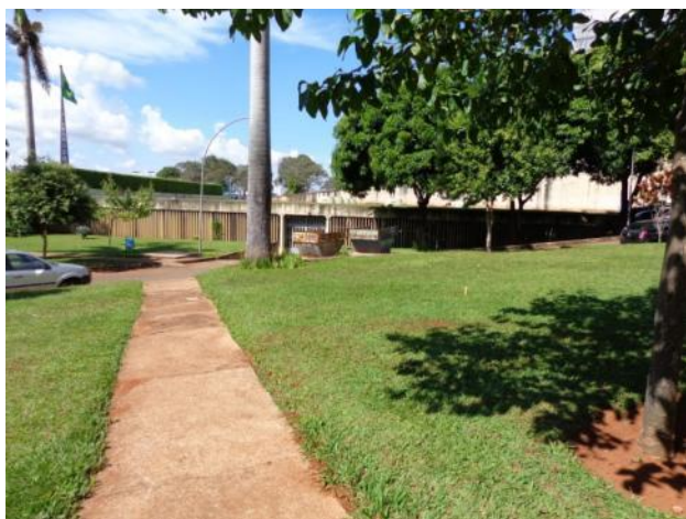
Casa de Máquinas 3
