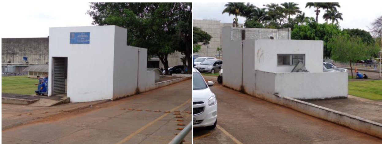
Casa de Máquinas 2
