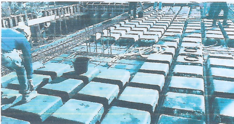
Figura 5: EXECUÇÃO DE LAJE NERVURADA
