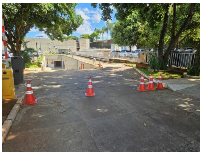
Figura 15- Rampa de acesso da Sala X - Prodase
