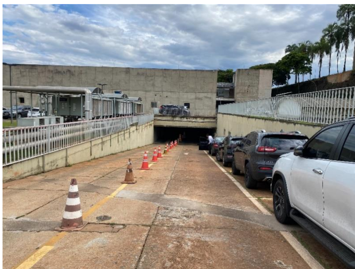
Figura 32- Acesso à garagem do Anexo II
