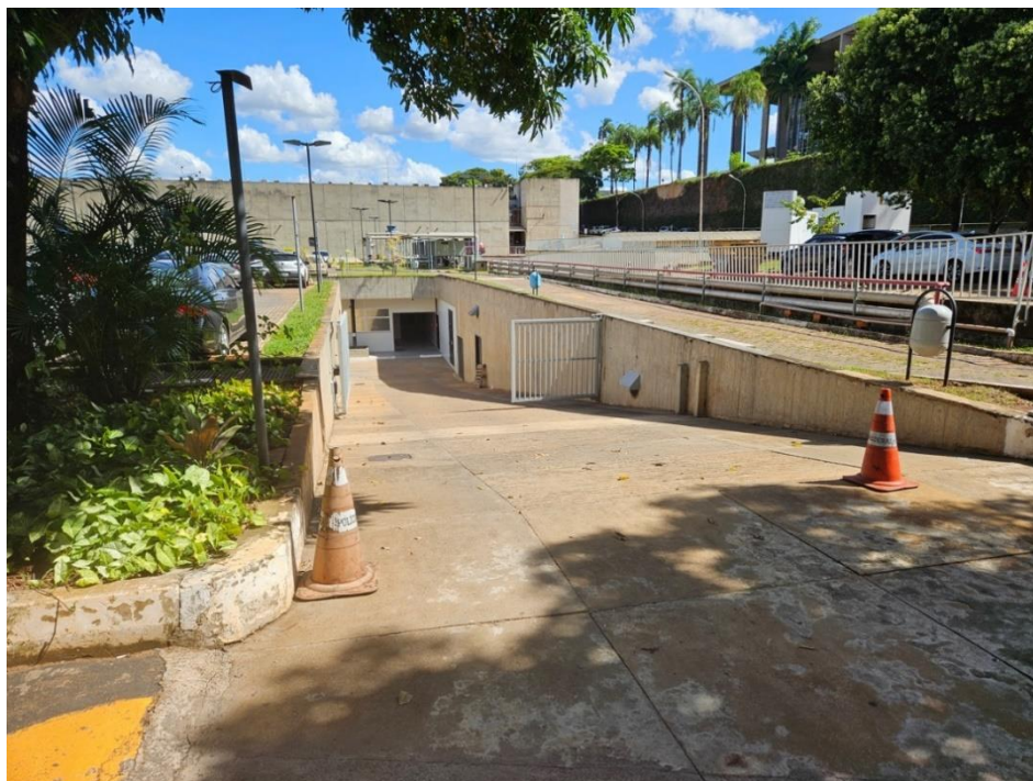
Figura 16- Rampa de acesso à Sala X - Prodasen
