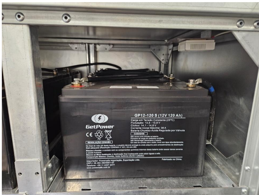
Figura 8 – Detalhe das baterias montadas na parte interna do banco de baterias
