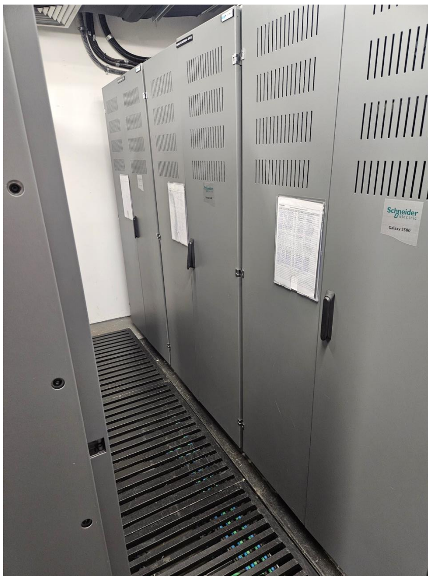
Figura 24 – Detalhe do espaço na frente de cada banco de baterias na sala X do Prodasen
