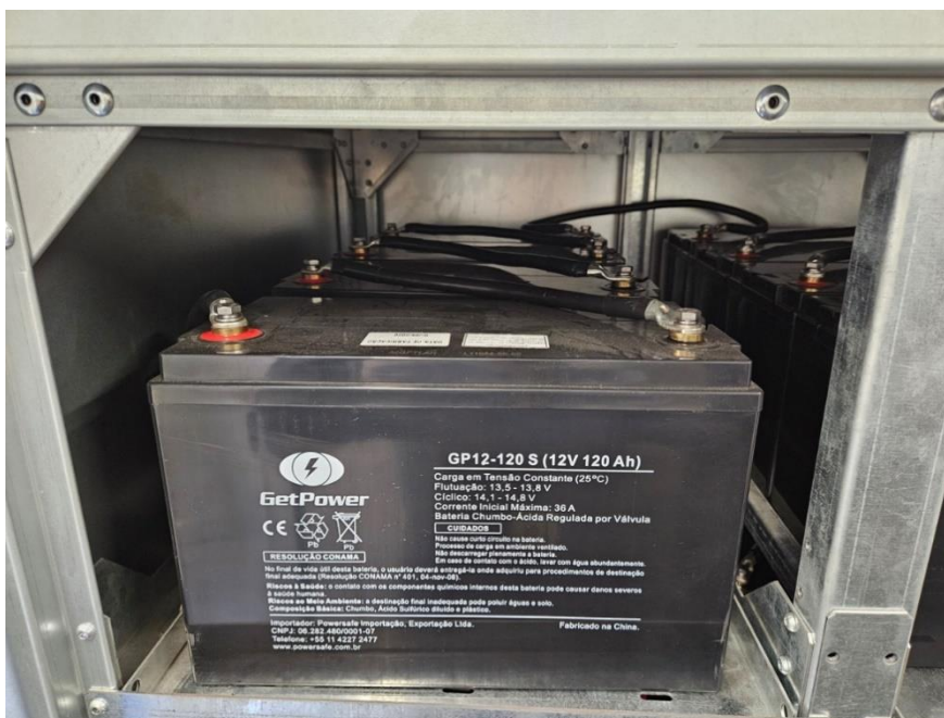
Figura 9 - Detalhe das baterias montadas na parte interna do banco de baterias
