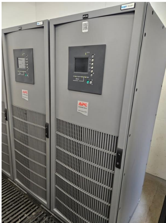
Figura 1 - Visão dos nobreaks do Senado Federal
