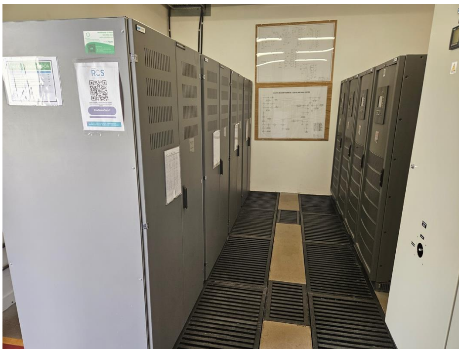
Figura 30 - Nobreaks do Ramal Y - Prodasen
