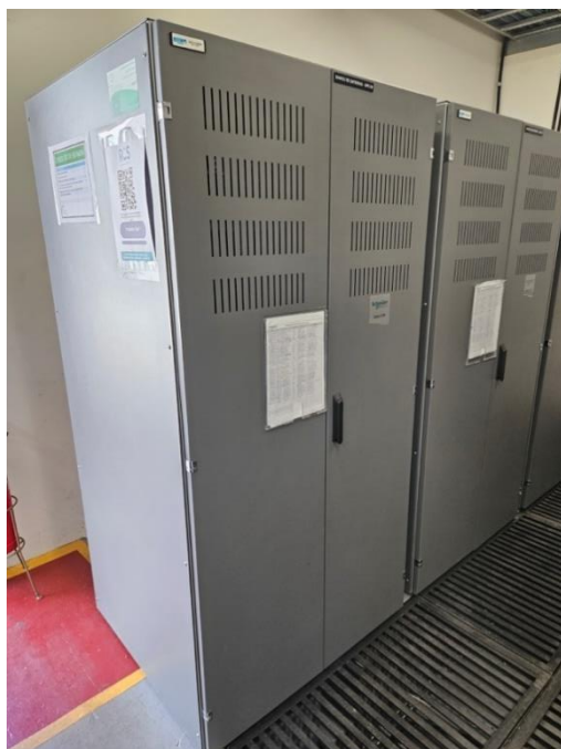
Figura 3 - Visão dos bancos de baterias dos nobreaks dos Senado Federal
