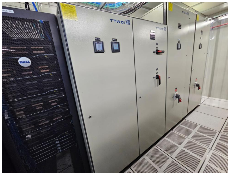
Painéis elétricos de distribuição (entrada de energia) – Sistema de energia ininterrupto (primeiro plano) e sistema de energia de emergência (ao fundo)
