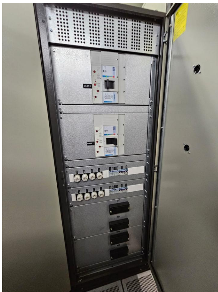
Visão interna de painel de distribuição de energia de emergência (coluna 1)
