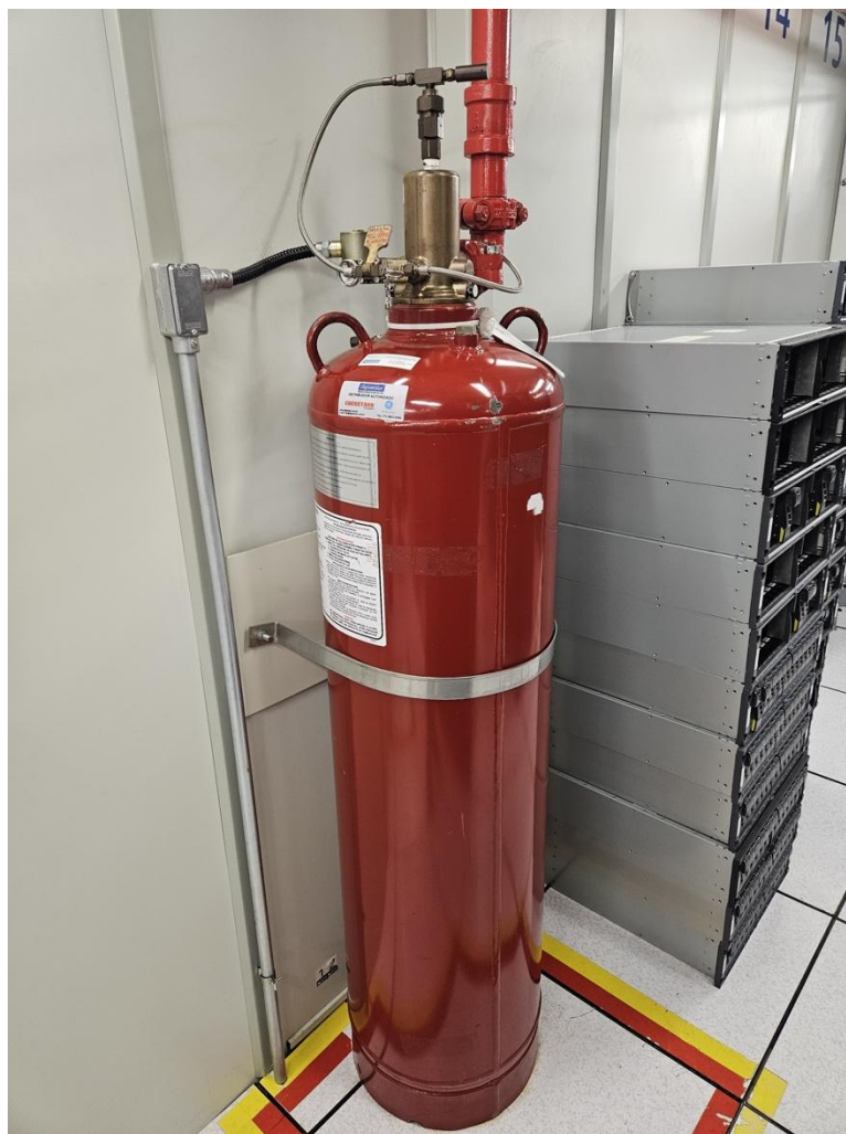
Vista geral do Cilindro 1 - 172,6 kg de FM-200
