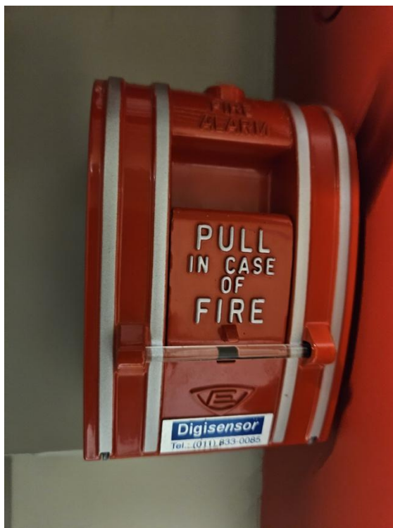
Detalhe de disparador manual instalado ao lado da central de detecção e alarme de incêndio do ambiente sala cofre
