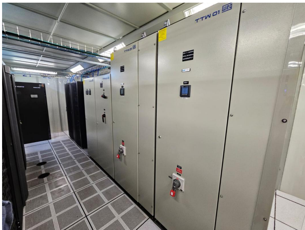
Painéis elétricos de distribuição (entrada de energia) – Sistema de energia ininterrupto (primeiro plano) e sistema de energia de emergência (ao fundo)
