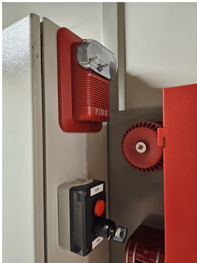
Detalhe do avisador sonoro-visual e chave de bloqueio instalados ao lado da central de detecção e alarme de incêndio
