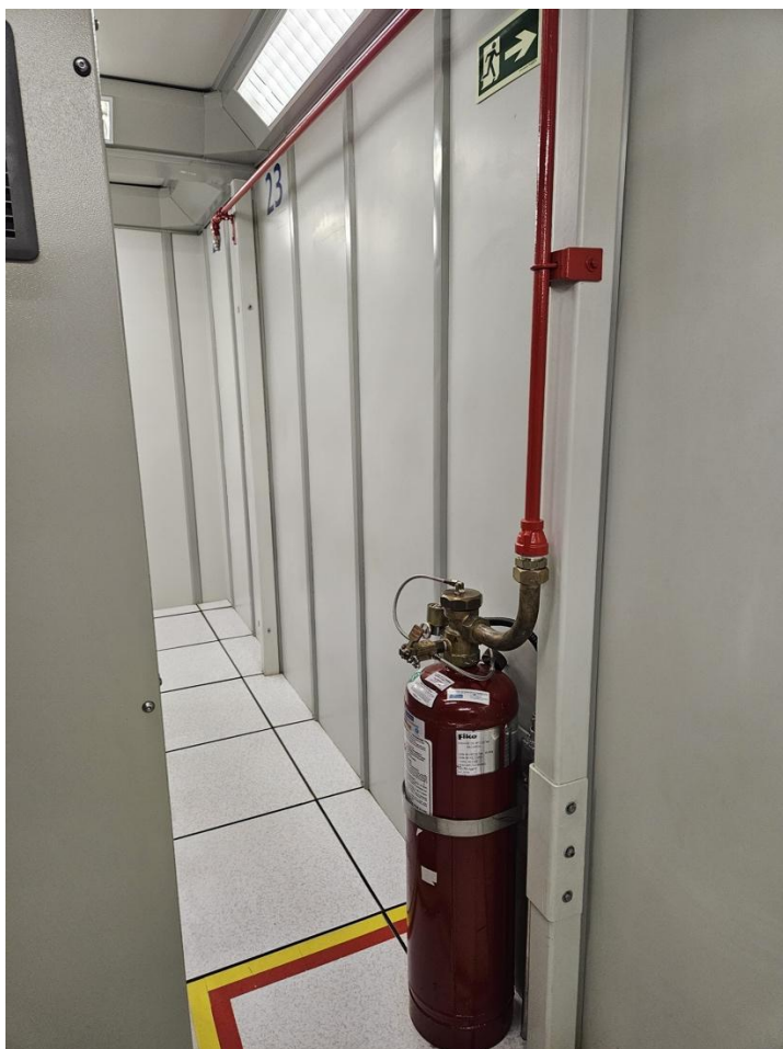
Vista geral do Cilindro 2 – 35,4 kg de FM-200
