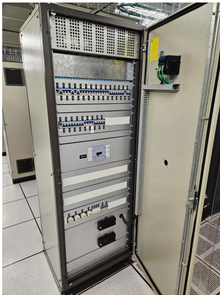
Visão interna de painel elétricos terminal de energia ininterrupta
