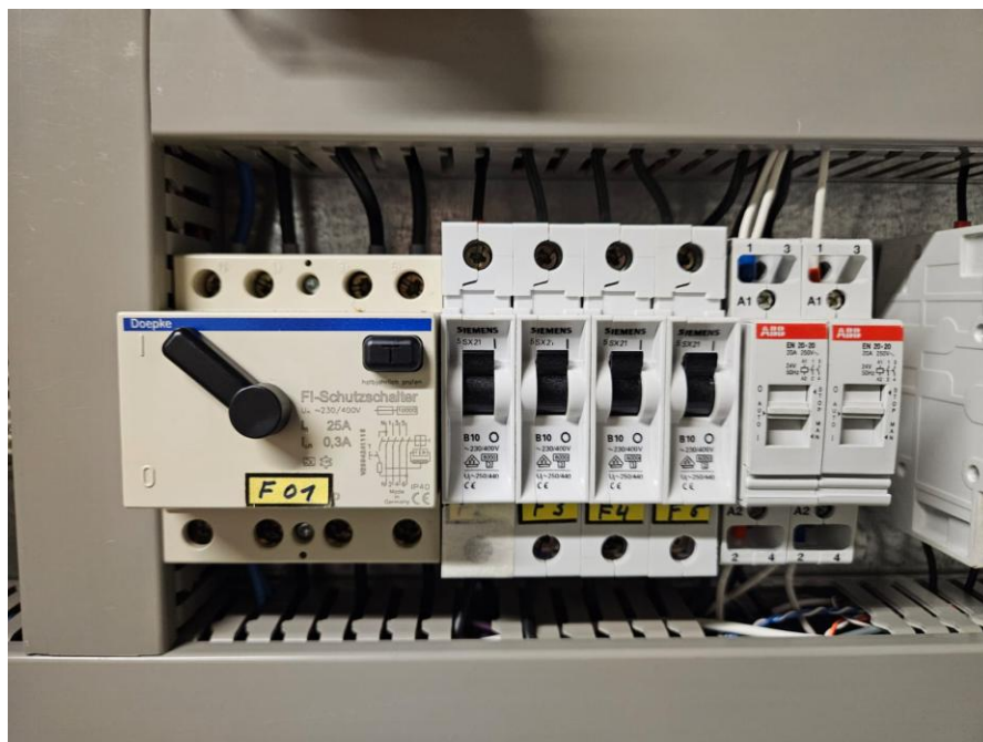
Alguns dos disjuntores, DR e contadora do sistema de controle e automação
