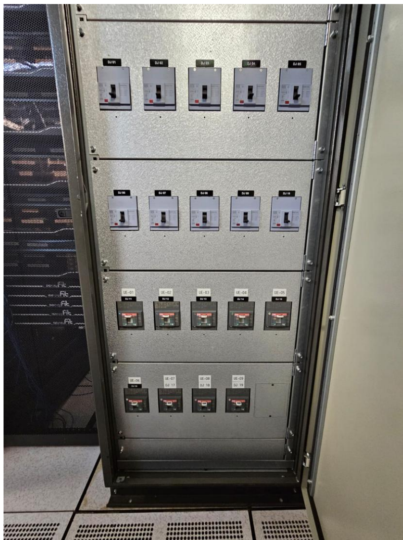
Visão interna de painel de distribuição de energia de emergência (coluna 2)
