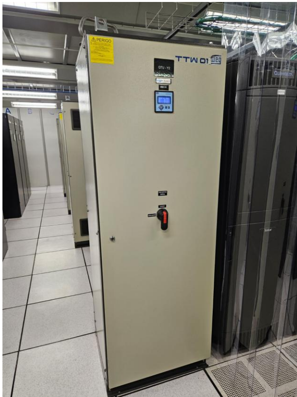
Painel elétricos terminal de energia ininterrupta
