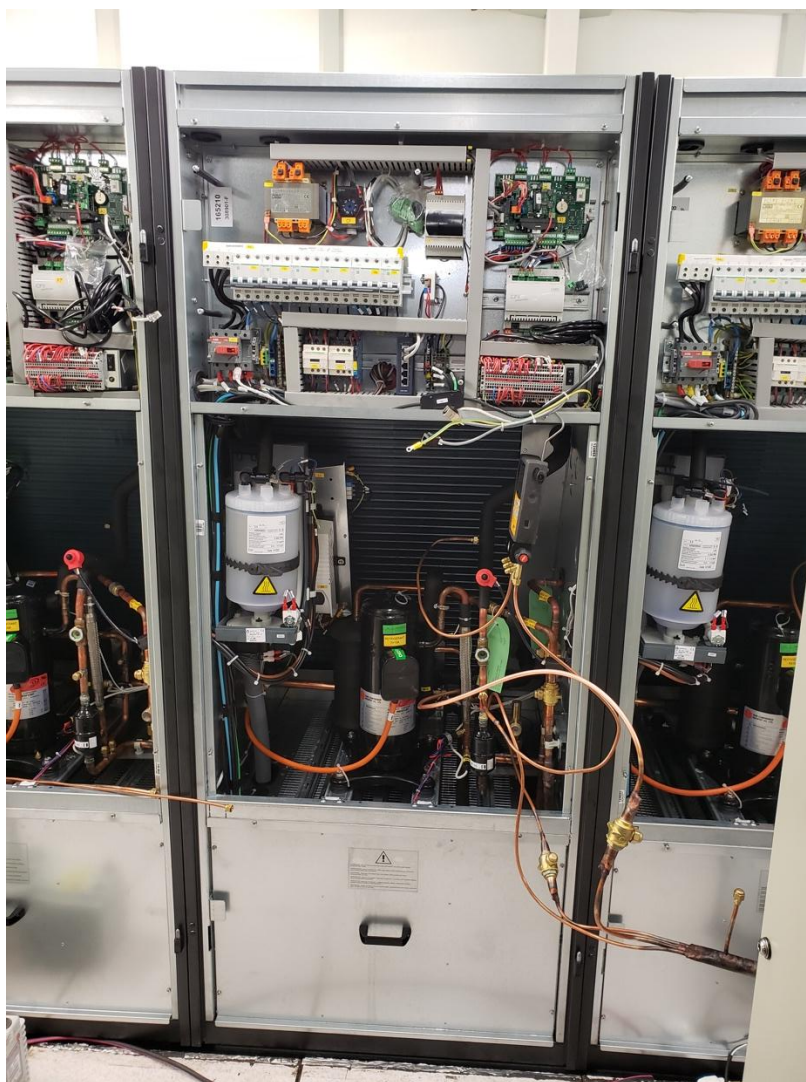
Vista interna de uma unidade evaporadora
