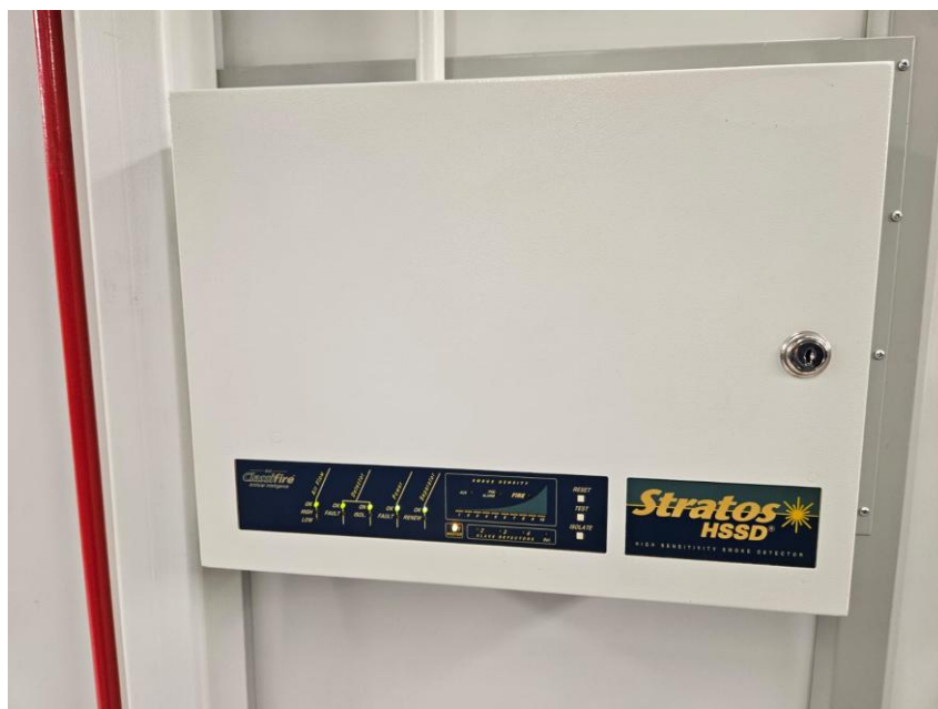
Sistema de detecção precoce (aspiração)
