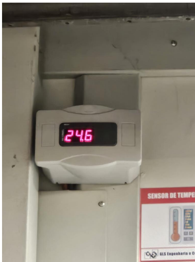
Painel de monitoramento de temperatura
