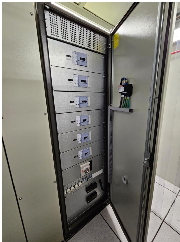
Visão interna de painel de distribuição de energia ininterrupta
